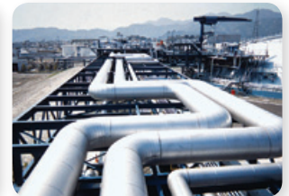
LNG保冷配管工事
