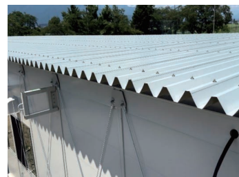
屋根材として使用
