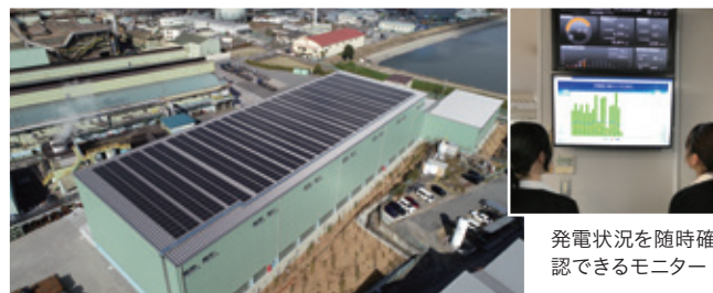
製品倉庫は2021年7月に竣工
