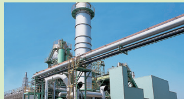
ガス化溶融炉
