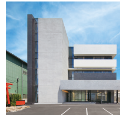
▲山口事業所 新事務所棟
