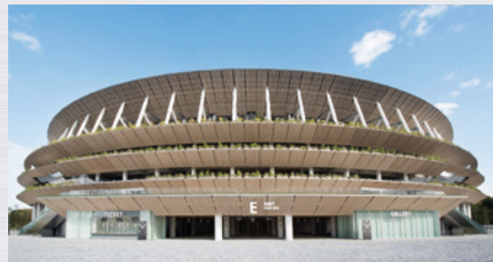
国立競技場／東京都（写真提供：独立行政法人日本スポーツ振興センター） ※関東スチール㈱より納入
