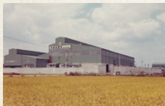
1971年に新設した枚方工場
