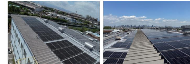
設備規模は、太陽光パネル915枚、総面積としては、2,363平方メートルであり、設備稼働による年間発電量は推定約572,000kWhです。CO<sub>2</sub>排出量は年間約175t-CO<sub>2</sub>が削減される見込みです。今後も太陽光発電設備の導入を拡大し、脱炭素社会の実現を目指してまいります。
