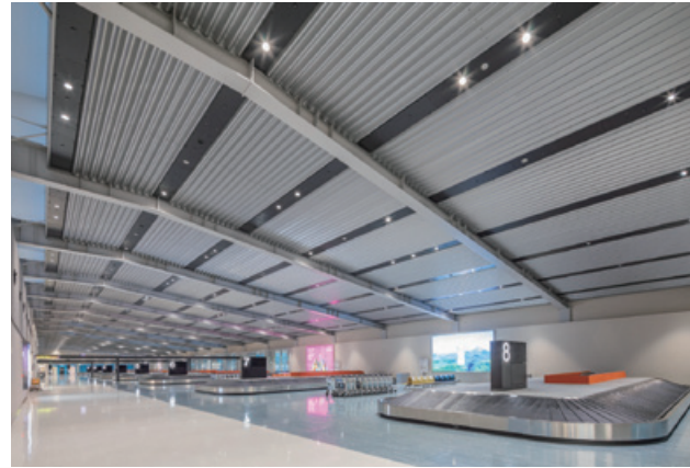
「ヨドルーフ」採用例 大阪国際空港 中央棟の天井
