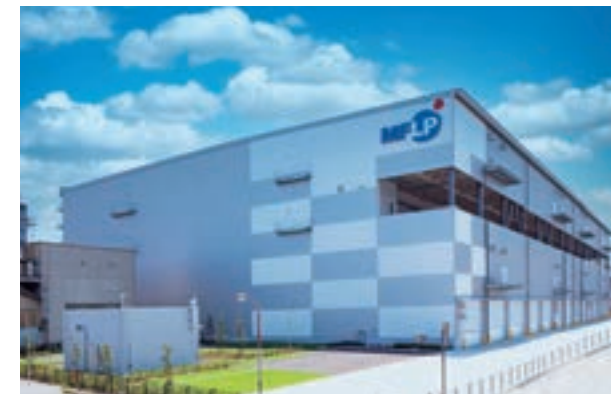
物流施設：MFLP大阪I 屋根材：ヨドルーフ166ハゼ 外壁材：ヨド耐火パネルグランウォール
