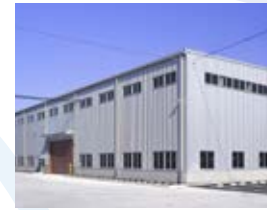
丸一鋼管(株)の名古屋新倉庫およびパイプセンター
