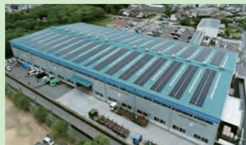
製品倉庫屋上の太陽光発電設備
