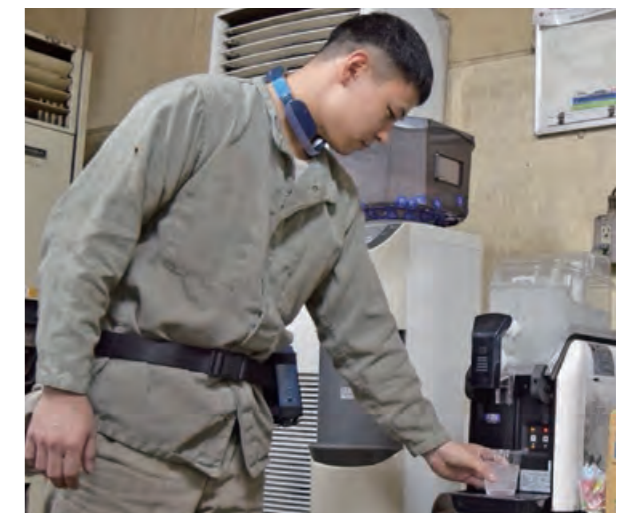
アイススラリー製造機の設置
