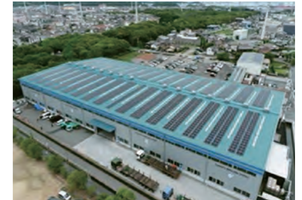
製品倉庫屋上の太陽光発電設備
