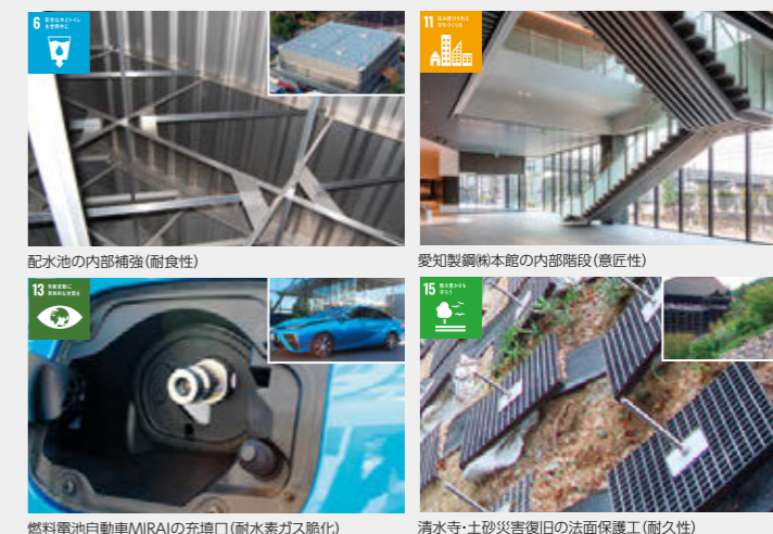
配水池の内部補強(耐食性) 愛知製鋼本館の内部階段(耐食性) 燃料電池自動車MIRAIの充電口(耐水素ガス腐化) 清水寺・土砂災害復旧の法面保護工(耐久性)
