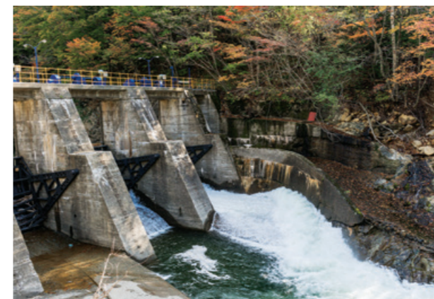
第2発電所堰堤
