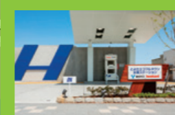
水素ステーション
