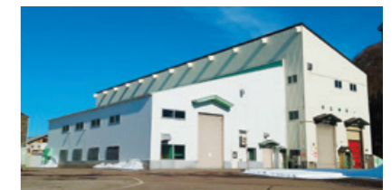
妙高工場リチウムイオン電池正極材製造工場外観
