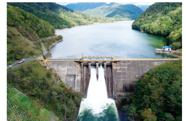
幌満川 第3発電所ダム
