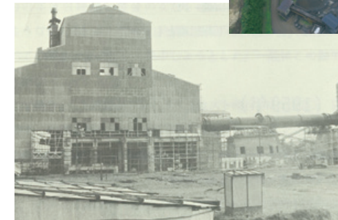
建設中の鹿島工場
