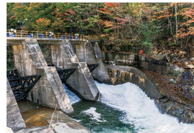
第2発電所堰堤
