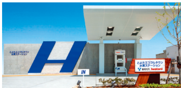
水素ステーション
