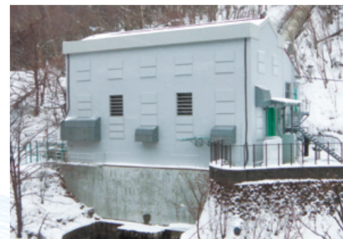
第3水力発電所
