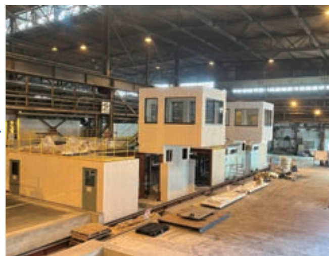
2024年10月 電気炉4基中2基の設置が完了
