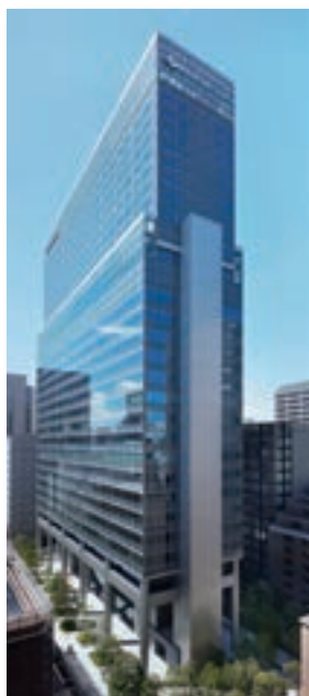
新オフィスビル外観
