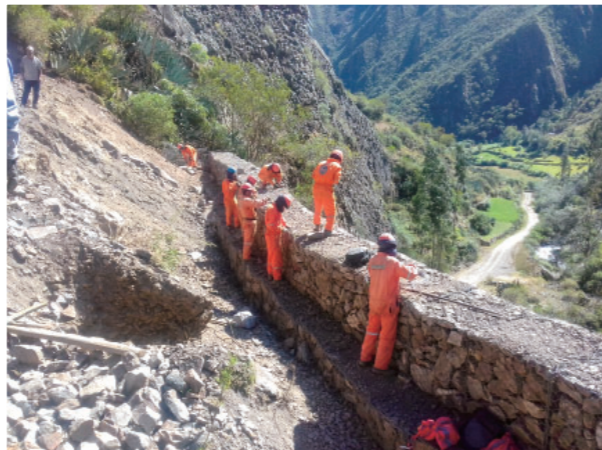
道路整備のため落石防止壁を設置しました(ジャマック村近郊にて)
