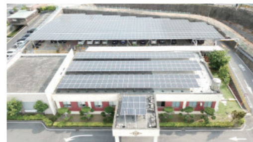
台湾銅箔 太陽光発電設備
