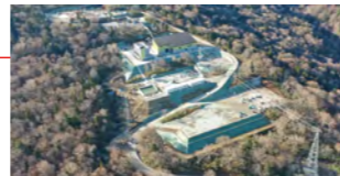
安比地熱発電所(建設工事全景)
