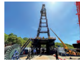
掘削調査の様子
