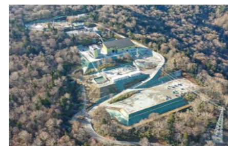
安比地熱発電所 (建設工事全景)
