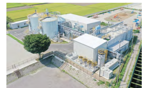
ニューエナジーふじみ野(株) バイオガス発電プラント
