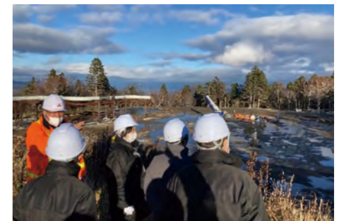
安比地熱発電所建設現場(岩手県)の視察
