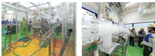
薬液・高圧水危険体感
