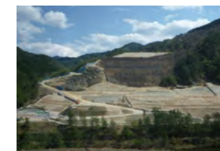
【地震対策】 生野鉱山集積場安定化工事（地盤改良）
