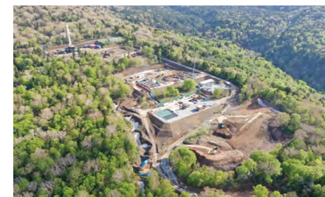
安比地熱発電所(岩手県八幡平市)(建設中)
