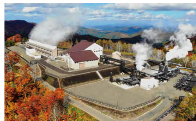
山葵沢地熱発電所(秋田県湯沢市)
