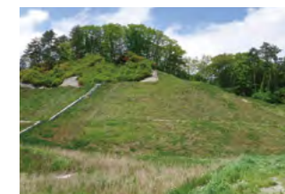
【降雨浸透制御・緑化】 小真木鉱山発生源対策工事（チップクリート）
