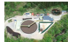
八谷鉱山坑廃水処理所(2019年度完成)
