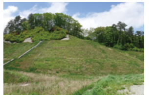
小真木鉱山発生源対策工事 (チップクリート)
