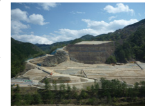
生野鉱山集積場安定化工事 (地盤改良)
