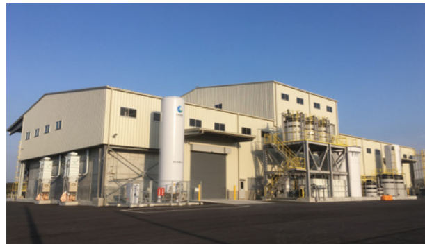
焼却飛灰リサイクル 家庭から排出される生活ごみ等を焼却した際に発生する焼却飛灰を脱塩洗浄し、セメント原料へと再資源化するリサイクル事業を推進しています。
