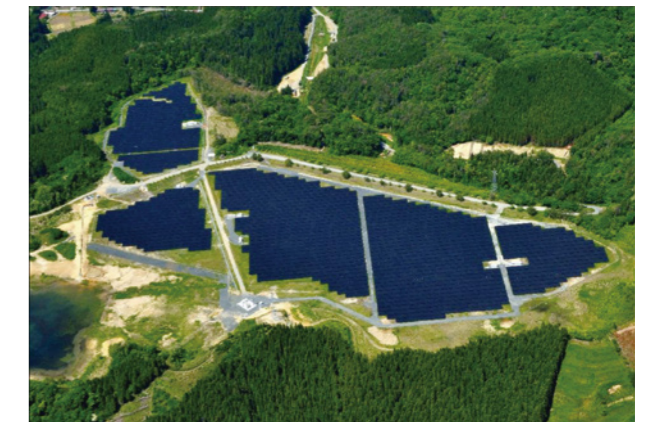
入釜太陽光発電所(宮城県栗原市) 事業主体: エルエムサンパワー(株) 2015年1月営業運転開始(出力6,930kW)
