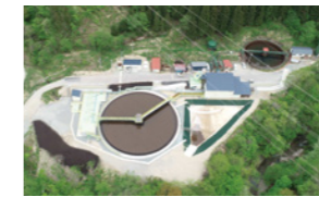
八谷鉱山坑廃水処理所 (2019年度完成)
