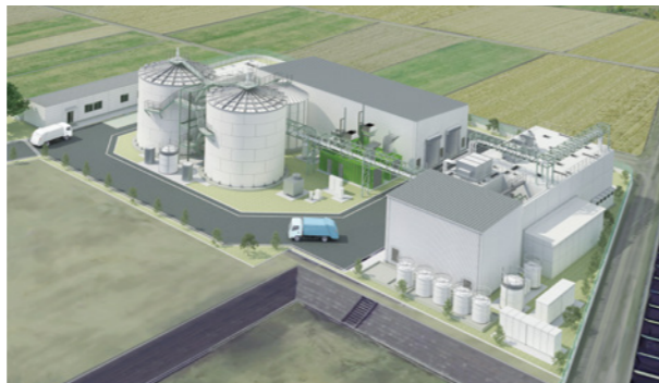
食品廃棄物バイオガス化 (ニューエナジーふじみ野(株): 2020年9月稼働予定) 食品工場や小売店等から排出される食品廃棄物をバイオガス化(メタン発酵)して再生可能エネルギー(電力)を創り出し、廃棄物の適正処理と社会へのエネルギー供給を同時に実現するリサイクル事業を推進しています。
