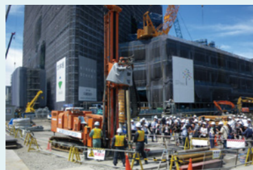
地中熱利用システム 工事の様子 (東京スカイツリー)
