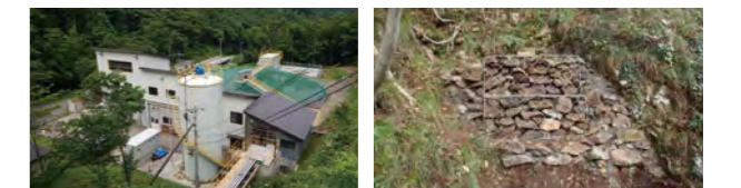
坑廃水処理管理(手稲鉱山) 坑道・坑口管理(佐渡鉱山)
