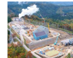
山葵沢地熱発電所 建設工事
