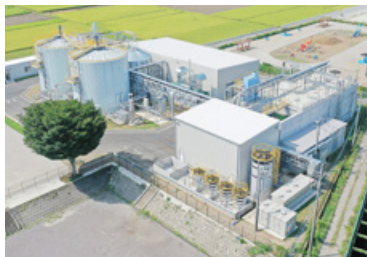
NEFCバイオガス発電プラント全景
