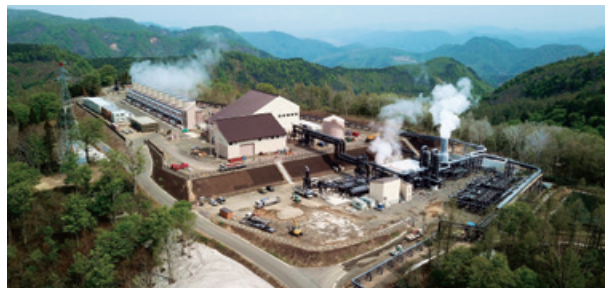
山葵沢地熱発電所全景
