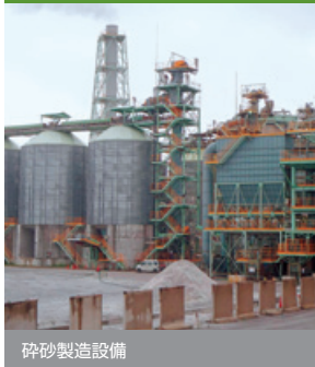
砕砂製造設備
