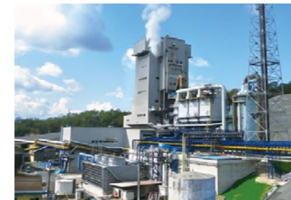
2007年に小坂製錬に建設したリサイクル専用炉
