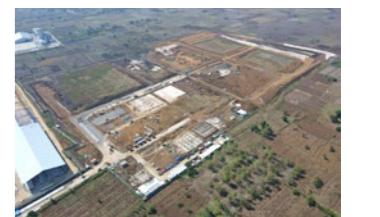
インドネシアの第2拠点(建設中)
