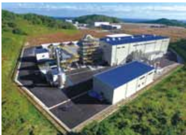
溶融・再資源化処理施設
