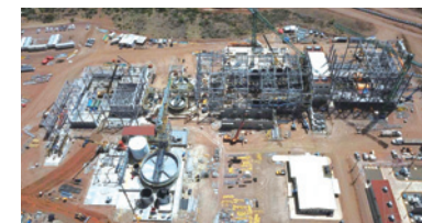
ロス・ガトス鉱山の設備(建設中)
