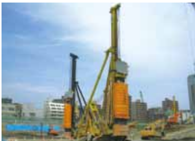
汚染土壌の現地浄化
