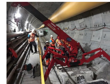
バッテリー式クレーン トンネル内でのクレーン作業
