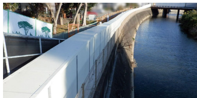
調節池造成工事 密閉式吊下げ型コンベヤ(SICON®)
