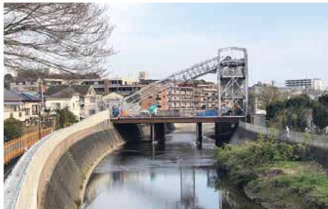
境川金森調整池造成工事(東京都町田市)向け密閉式吊下げ型コンベヤ
