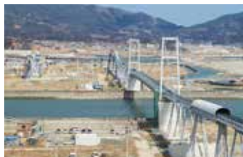
陸前高田市における高台移転工事 (2014年度設置完了、2016年度解体)
