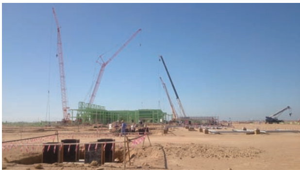
サウジアラビアで進む工場建設
