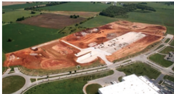
順調に整地が進む米国合弁会社の工場建設用地
