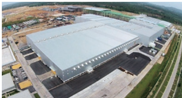
鋳造工程からの一貫製造に向けて建設中のラヨン製造所
