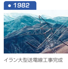
● 1982 イラン大型送電線工事完成
