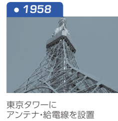
● 1958 東京タワーにアンテナ・給電線を設置
