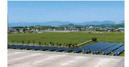
古河AS(株)本社工場:太陽光発電パネル設置(2022年1月稼働開始)
