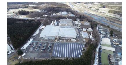
銅箔事業部門今市東工場:太陽光発電パネル設置(2019年2月稼働開始) 再生可能エネルギー由来電力導入(2022年4月導入開始)
