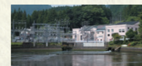
古河日光発電(株)の水力発電(細尾発電所)
