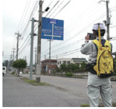
AR(注)を用いて道路付属物を点検
