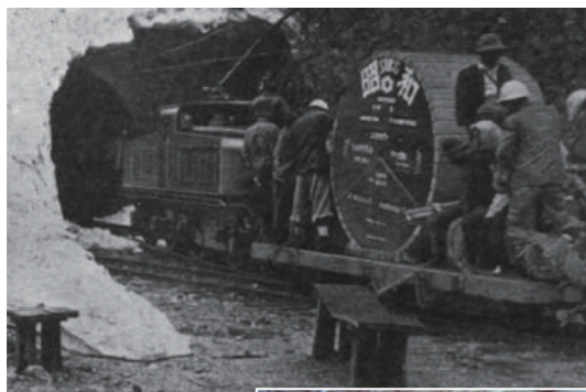
黒部川送電工事 (1956年撮影)
