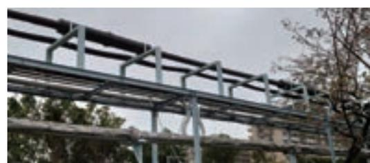
ケーブルラック上(高さ5m)に敷設された超電導ケーブル
