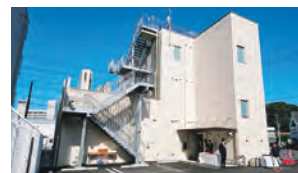
屋上へつながる外部階段
