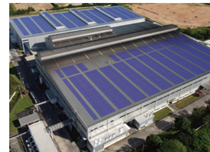
リョービダイキャスト(タイランド)CO.,LTD.に設置の太陽光パネル
