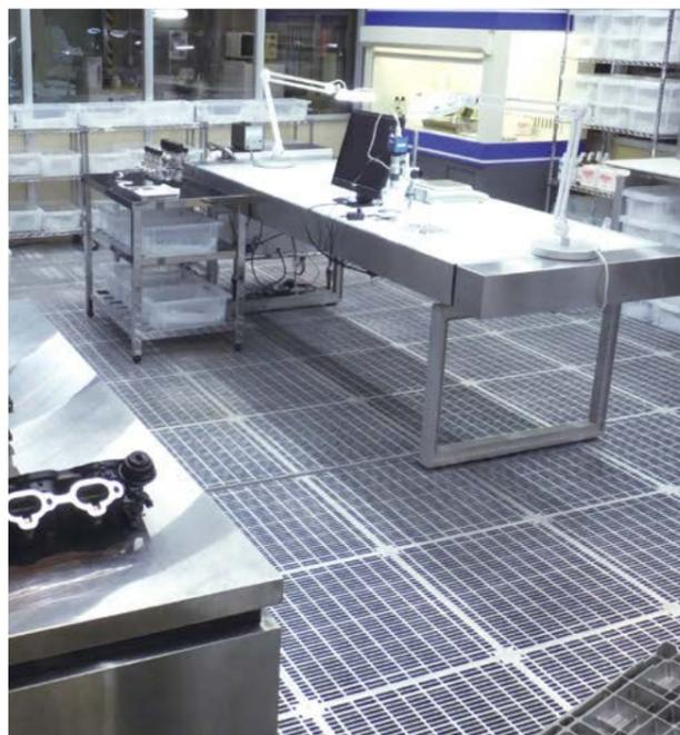
1962年、アーレスティは日本で最初のアルミニウムダイカスト製のフリーアクセスフロアパネル「モバフロア」を開発しました。フリーアクセスフロアとは、配線・配管を床下に納める二重床システムのことです。一般オフィスや病院などに幅広く利用されていますが、当社では特に半導体生産工場などのクリーンルームやデータセンター、コンピュータールーム用フロアパネルに注力しており、クリーンルーム向けでは、国内シェア No.1 を誇っています。
