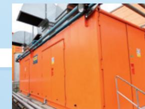
「バイオ発酵タンク」は、投入された原料のメタン発酵処理を行う設備です。ここで生成されたバイオガスは、「ガスクーラー」で除湿され、「脱硫塔」にて硫化水素を除去され、燃料として「発電機(エンジン)」へ供給されます。
