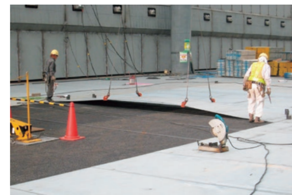
多治見市処分場施工状況
