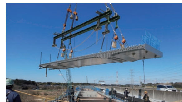
プレキャスト合成床版の架設
