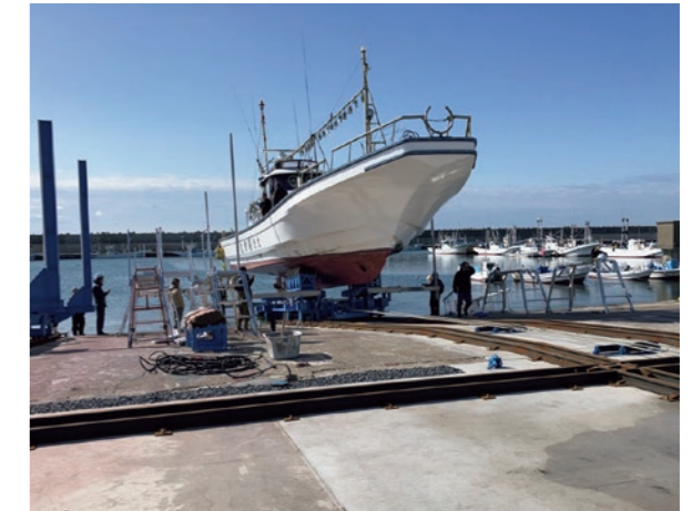
大洗漁港ラップ式上架施設
