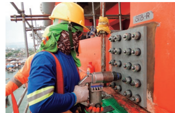
片面施工ボルトによる当て板補強（フィリピン）
