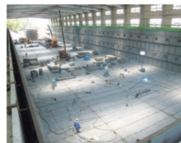
多治見市処分場施工状況2
