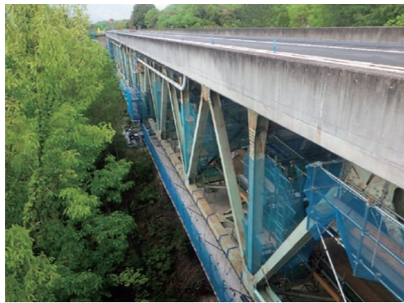
玉振谷橋他2橋耐震補強工事
