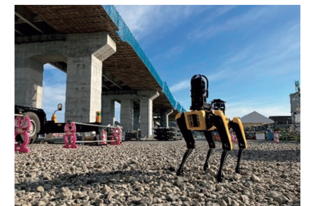
4足歩行ロボットによる安全巡視
