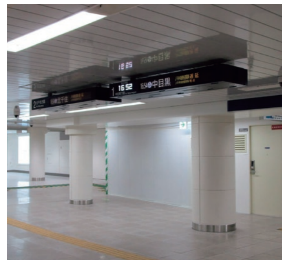
神谷町駅鋼管柱
