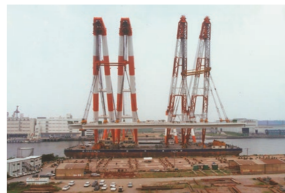
東京湾アクアラインの地組立状況
