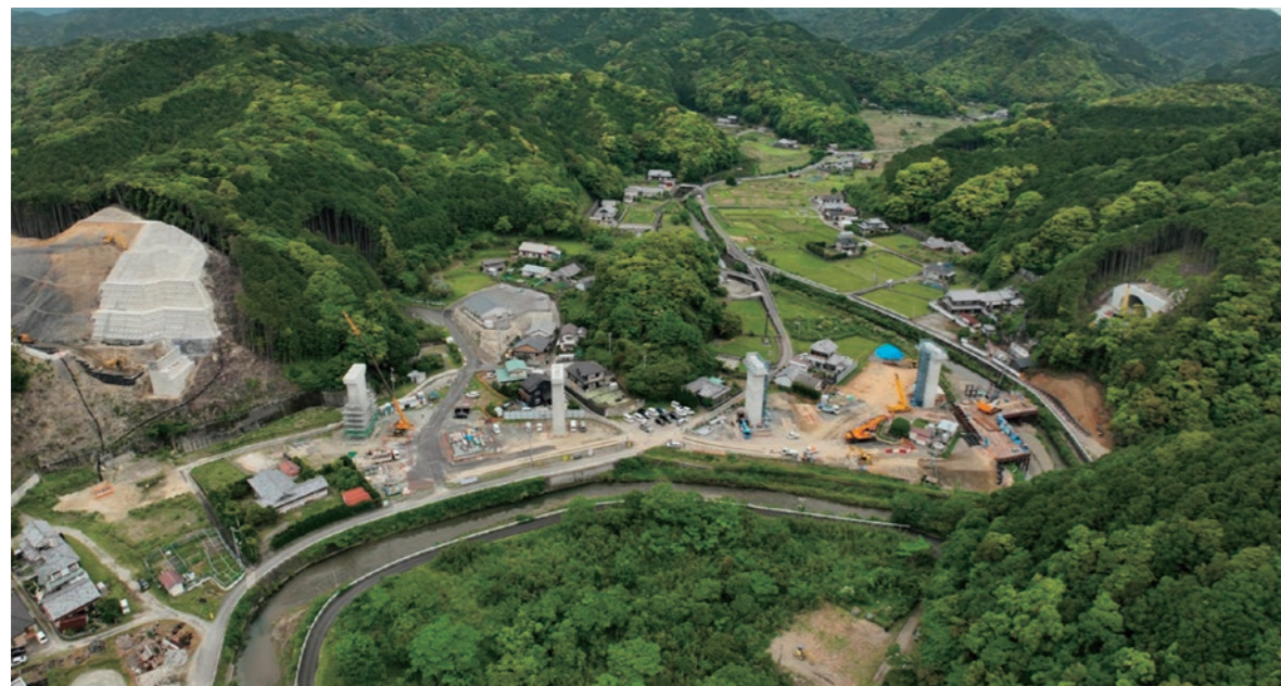
田並川橋（現場）
