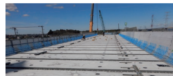
プレキャスト合成床版の架設完了状況
