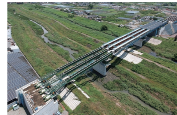
瀬川・平等川橋の送り出し架設
