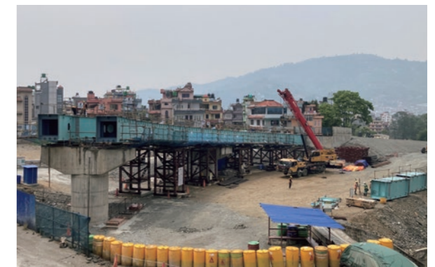
架設中のバランブ高架橋（ネパール）
