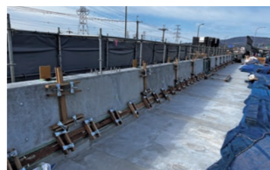
ラピッドガードフェンス (中国自動車道 荒牧高架橋)
