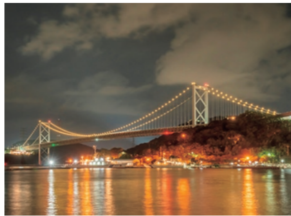
関門橋主ケーブル送気設備設置他工事
