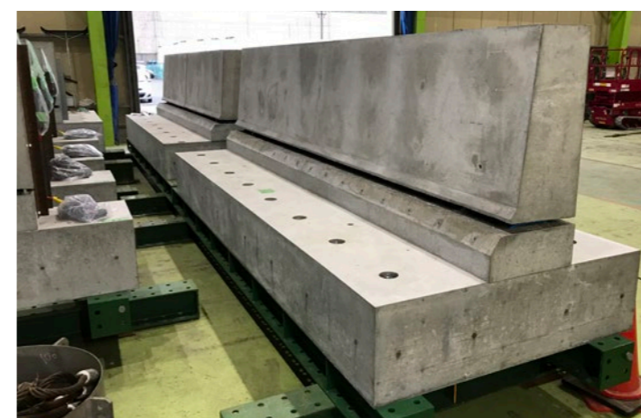
ラビッドガードフェンス（プレキャスト壁高欄）
