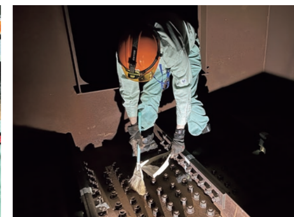
箱桁内の清掃
