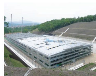
多治見市処分場施工状況3
