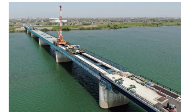
新濃尾大橋（A1-P5）の合成床版架設
