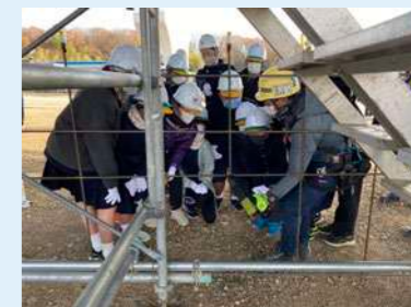
工事現場で実施した作業体験の様子
