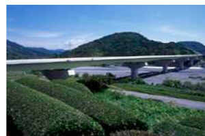
新東名高速道路・大井川橋 (橋長704m)
