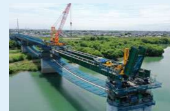
手延べ桁回転状況
