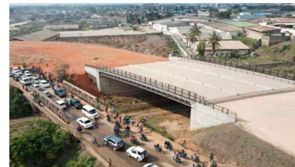
完成したゲレザニ橋（タンザニア）
