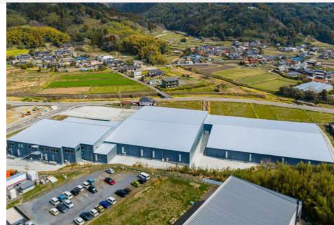
工事名称：株式会社友樹飲料 倉庫棟 建築概要：延床面積 9,698m 2 所在地：佐賀県小城市小城町岩蔵 2575-3 建物幅80m×建物長170m×軒高12m
