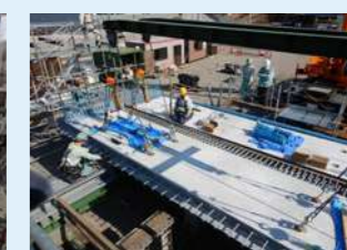
実物大施工試験による施工性の検証
