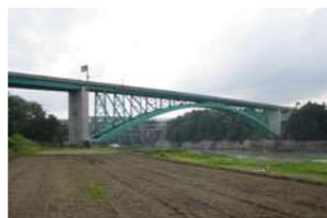
磐越自動車道・只見川橋 (橋長311m)
