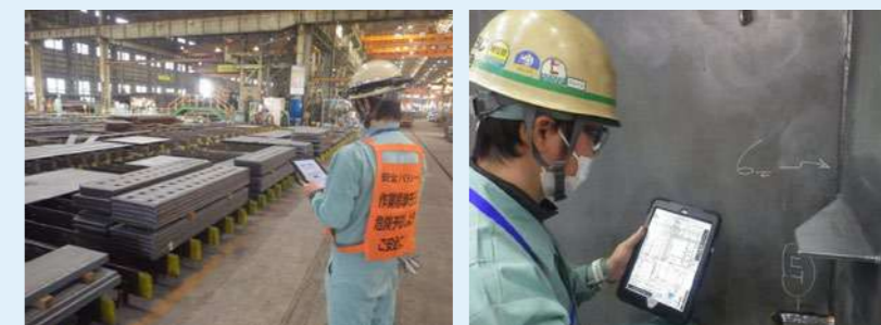
パトロールにおける指摘事項をタブレットに入力 タブレットで図面確認
