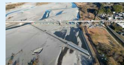
河川内での橋桁架設状況
