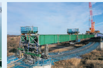
P6支承運搬状況
