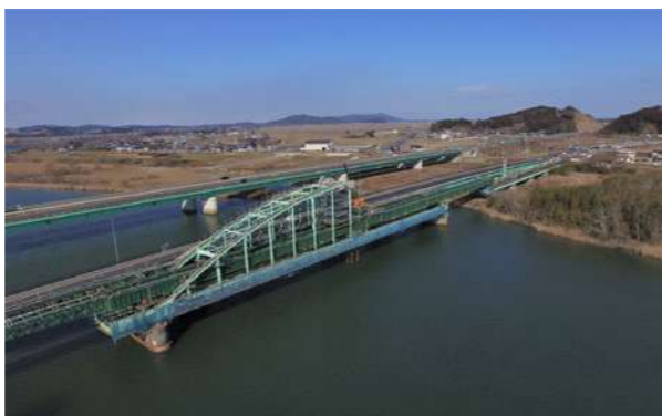
天王橋のアーチリブ撤去工事（宮城県石巻市）
