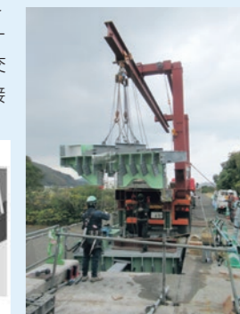
鋼床版への取替状況
