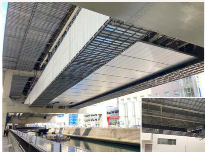
▲恒久足場「cusa」の設置状況
