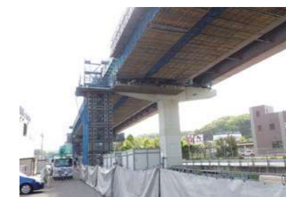
佐世保道路 沖新高架橋
