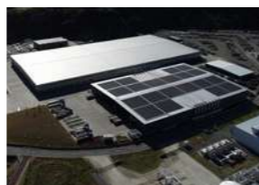
横河システム建築 茂原工場に太陽光発電設備を設置
