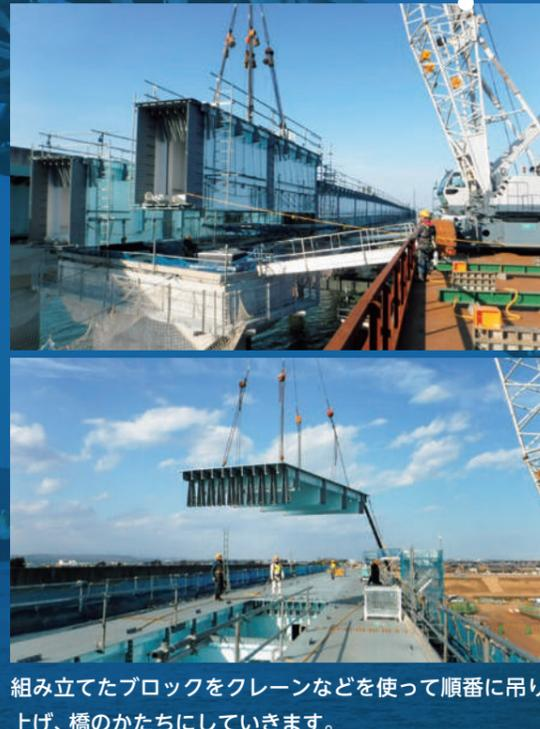
組み立てたブロックをクレーンなどを使って順番に吊り上げ、橋のかたちにしていきます。
