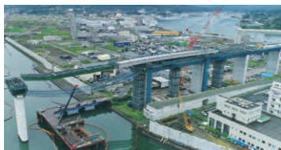
送出し架設（写真左側の桁先端の斜め上方に折れている箇所が「たわみ処理装置」）
