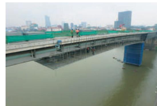
チュレイチョンパー橋 補修塗装用のパネル足場の設置
