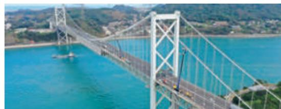
高所作業車による主ケーブル上の作業足場の設置
