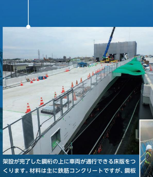
架設が完了した鋼桁の上に車両が通行できる床版をつくります。材料は主に鉄筋コンクリートですが、鋼板を用いて工場で製作する鋼床版もあります。
