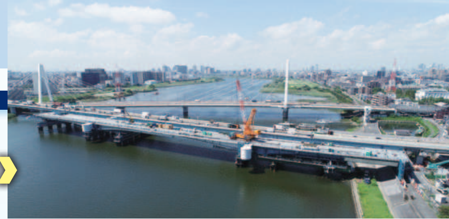
新設橋組み立て完了
