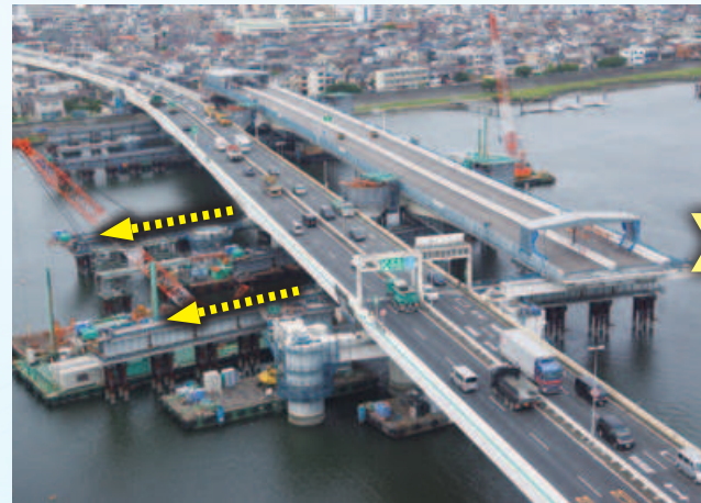
既設橋横取り前(左:既設橋 右:新設橋)
