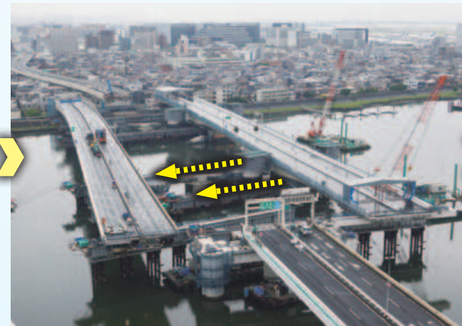
既設橋横取り完了
