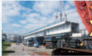
2径間を地上で組み立て
