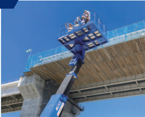
高所作業車で架設現場へ
