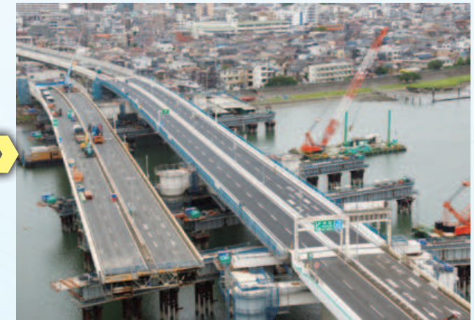
新設橋横取り完了
