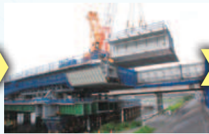
1径間はトラバークレーンで架設
