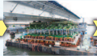
台船リフトアップ工法で架設
