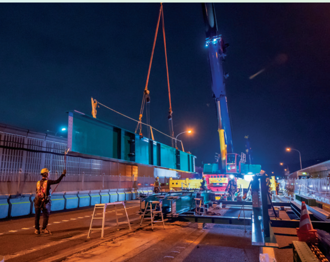
鋼桁架設状況
