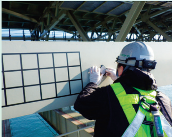
塗膜劣化調査
