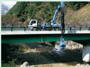
橋梁点検車による下面点検
