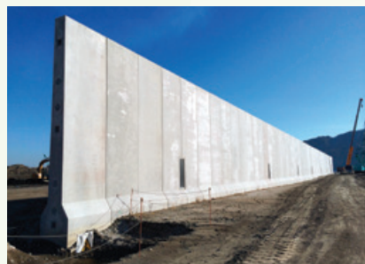
津波や高潮による被害を低減する「防災用プレキャスト防潮堤」
