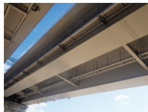
高島深沼橋(東北中央自動車道・上下線)工事に使用された「KERO」
